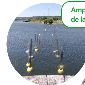
Montage de la barrière électrique à Ampsin
