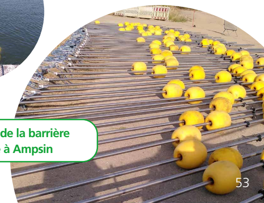
Ampsin-Neuville : mise à l'eau de la barrière électrique
